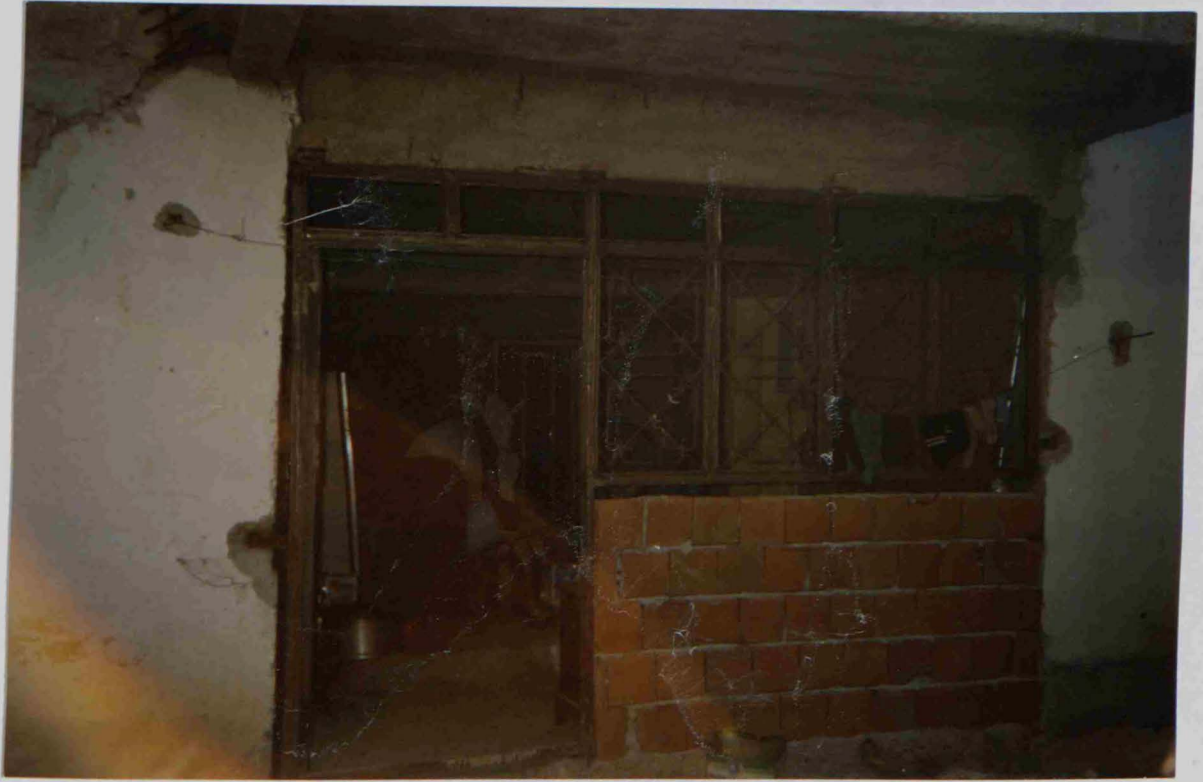
FOTO No: 29 ERWERK Evi
