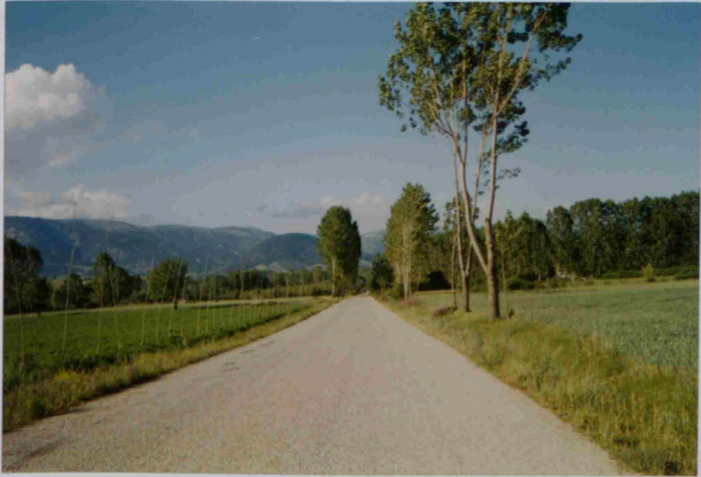
FOTO NO: 20 İLÇEYE ULAŞIM
