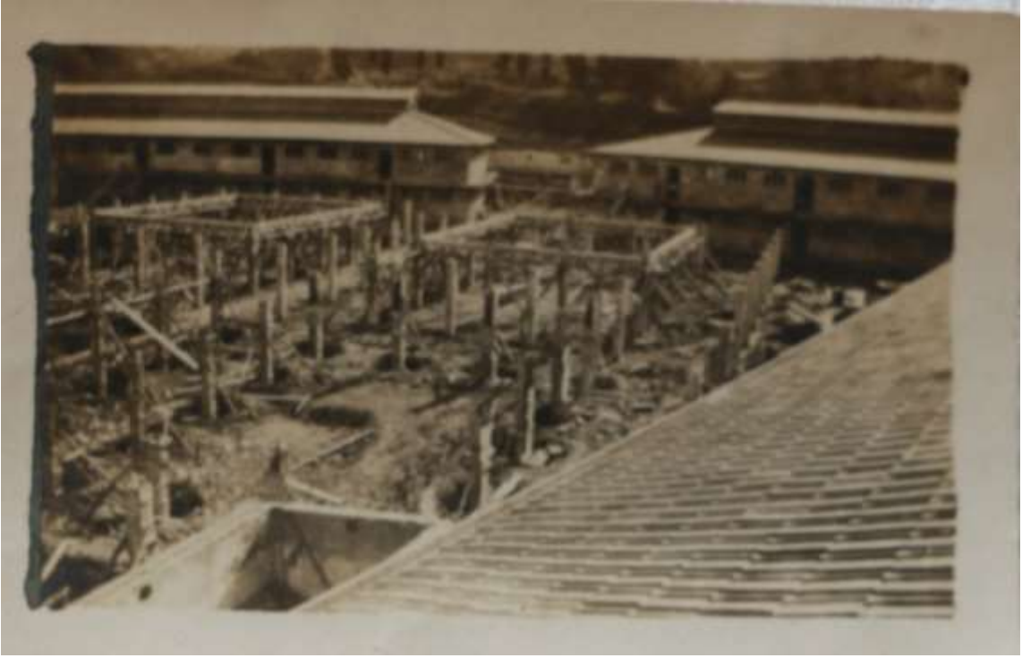
Karaağaç Mezbahası Pay Mahalli İnşa Halinde (F. Bengi Seyyidoğlu Arşivi'nden)
