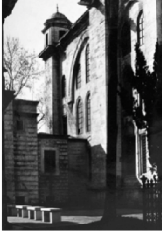
Resim 38: I.Mahmud Kütüphanesi'nin Fatih Camii'ne Bağlantısı.
