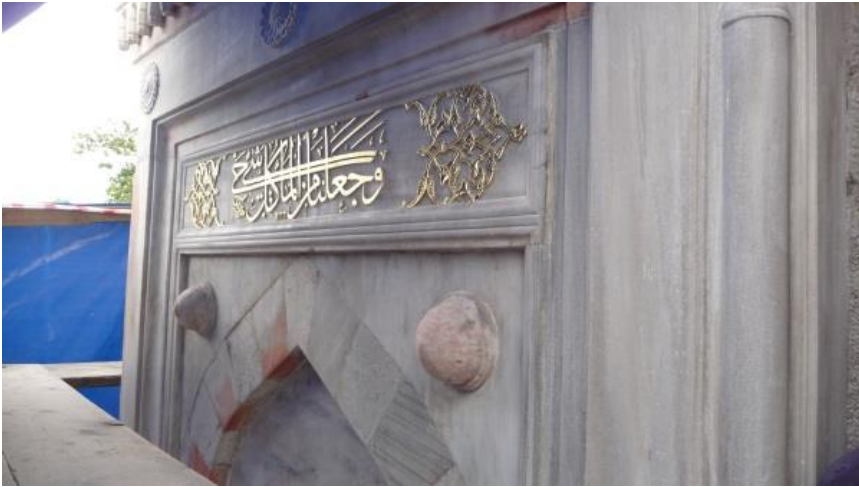
Resim 6. Restorasyon ve Konservasyon Çalışması Örneği (D. Demir Doğan, İBB-KUDEB, Üsküdar, 2012)
