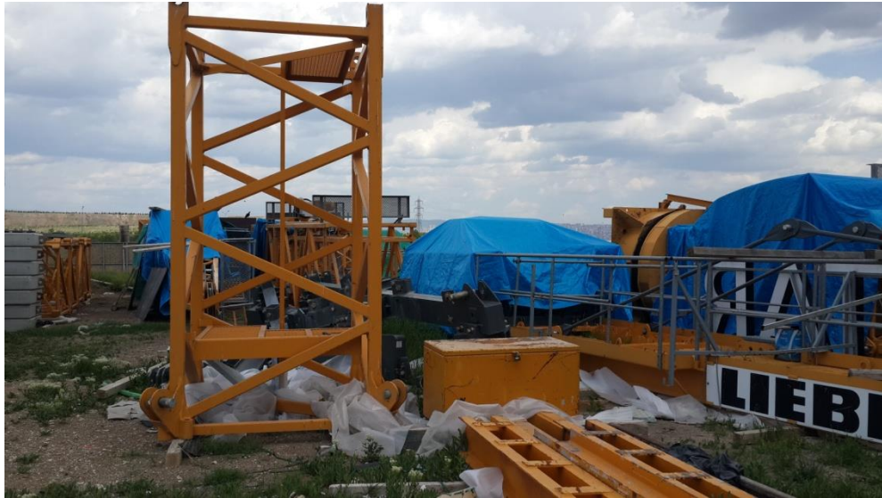
Şekil 47. Kule vinç stoklama sahası
