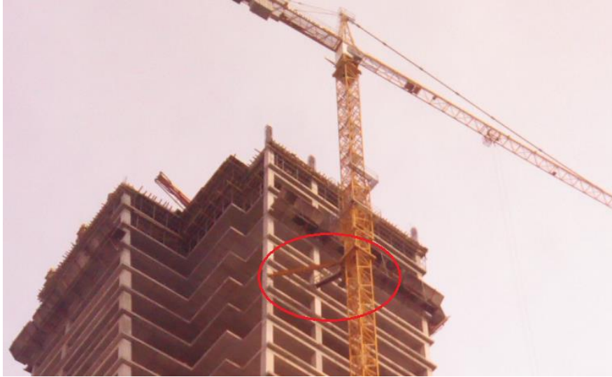
Şekil 37. Vinç-bina geçiş yolu
