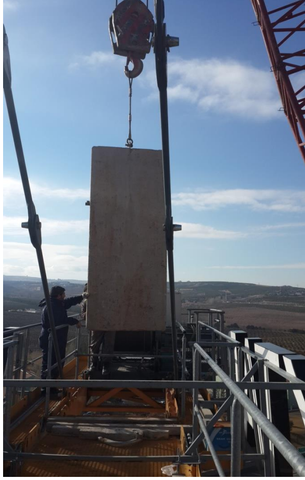
Şekil 33. Kuyruk grubu denge ağırlıklarının yerleştirilmesi
