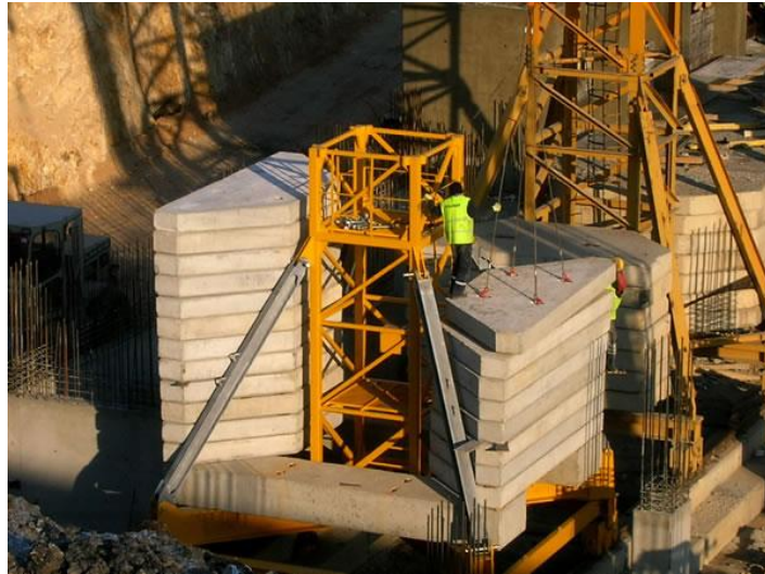
Şekil 30. Taban elemanı ve denge ağırlıklarının yerleştirilmesi
