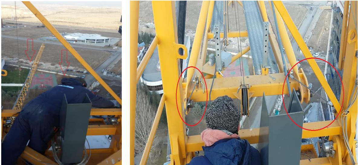
Şekil 42. Mobil vinç ile kuyruk grubunun ve bomun sökülmesi
