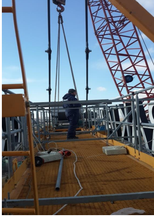
Şekil 34. Kuyruk grubunda reklam tabelasını tutan profiller
