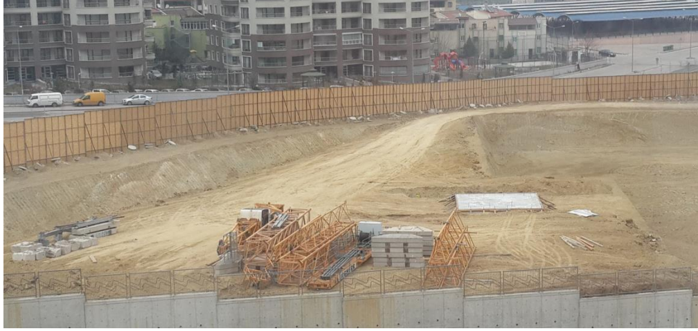
Şekil 29. Kurulum için sahaya getirilmiş kule vinç parçaları
