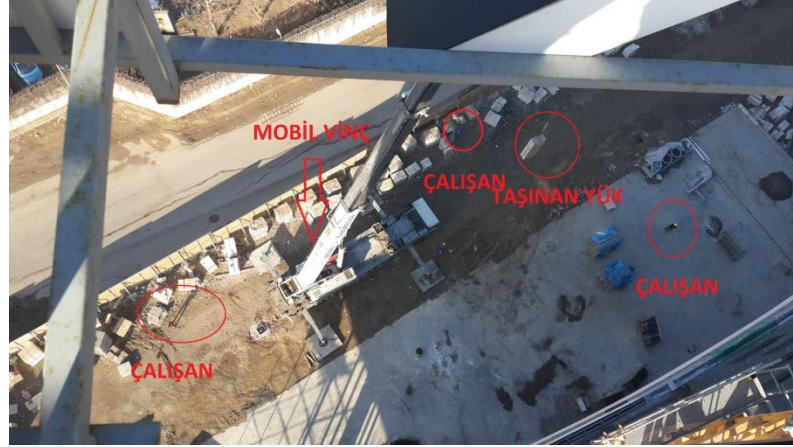
Şekil 41. Kule vincin sökülmesi ve mobil vinç çalışma alanı
