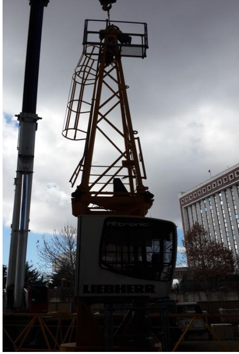
Şekil 44. Kule tepesine çıkış merdiveni
