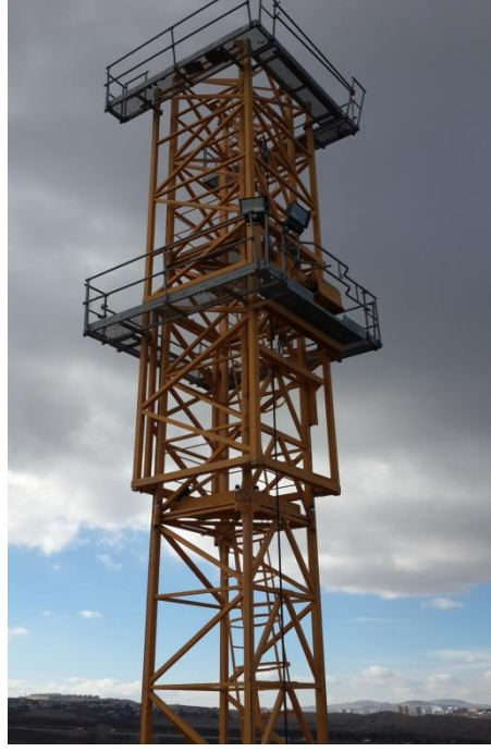
Şekil 45. Bomu, kule tepesi ve kuyruk grubu sökülen kule vinç teleskopu
