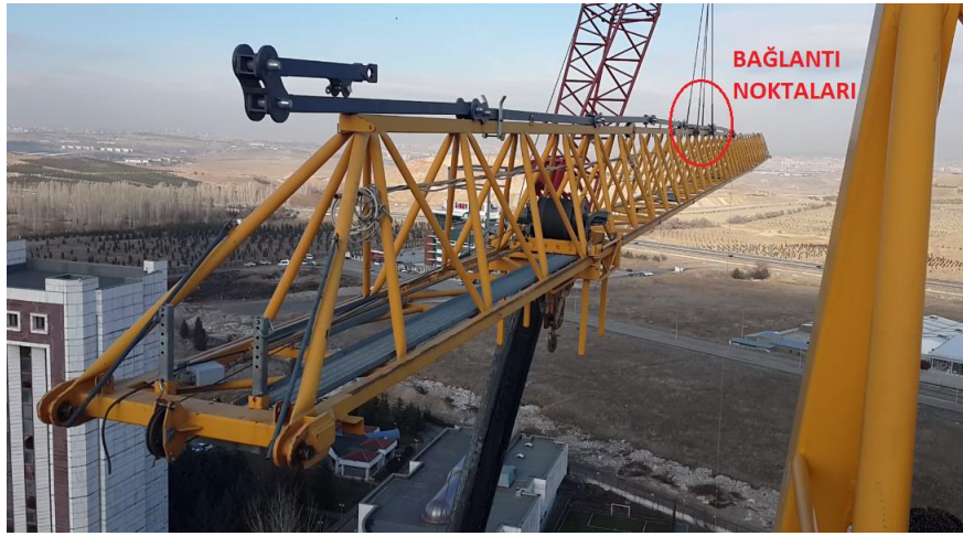
Şekil 43. Mobil vinç tarafından bomun aşağıya indirilmesi
