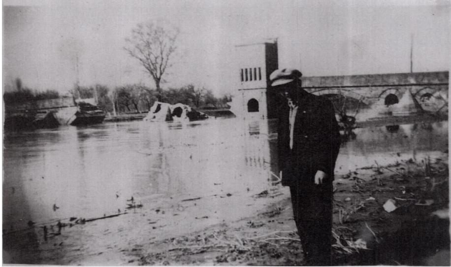
Foto 3: 15 Şubat 1947 Tunca Köprüsü Yıkılmış Vaziyette (Kazancıgil, 1995).
