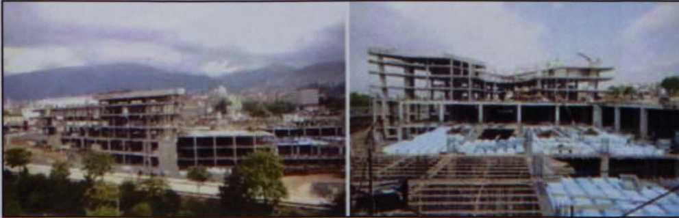
Şekil 3.19. Kent Meydanı AVM İnşaatı (2007)
