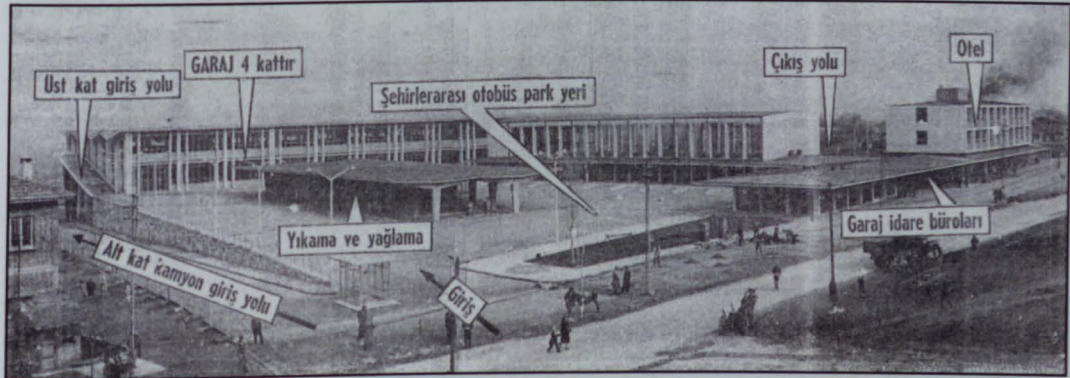
Şekil 3.2. Yapıldığı Yıllarda Santral Garaj Kompleksi
