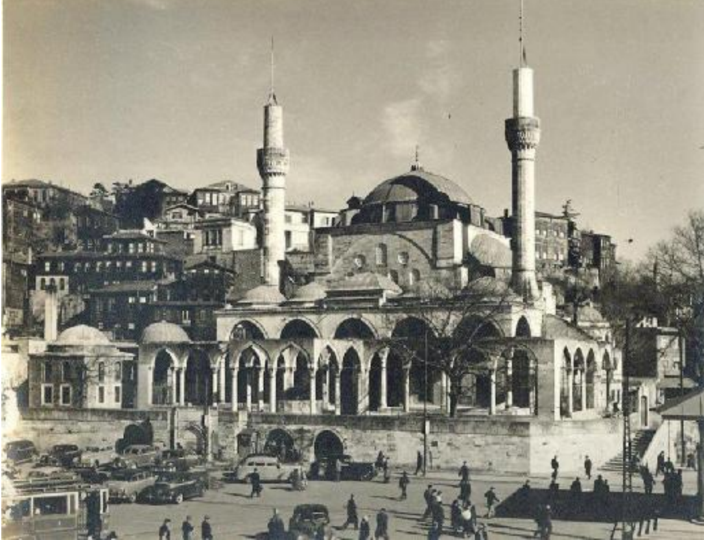
Fotoğraf 19 Üsküdar Mihrimah Sultan Camii dış revaklarının sökülmüş halinin fotoğrafı
