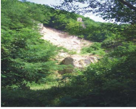
Foto : 11 Korgan yolu üzerinde gerçekleşen kaya düşmeleri.
