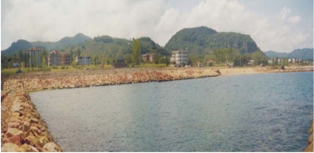
Foto: 77 Sahil yolunu dalgalardan korumak amacıyla yapıla “T” şekilli mahmuzlar, kıyı morfolojisini değiştirmiştir.
