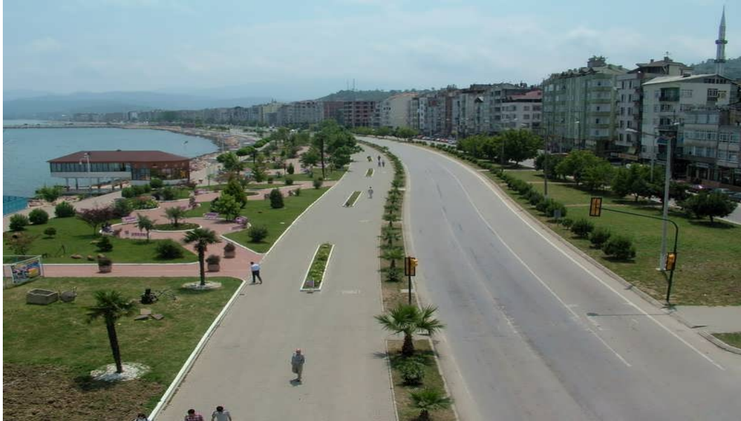
Foto:74 Sahil yolu ve kıyıdaki sosyal tesisler. Kıyı doldurularak oluşturulan platform üzerinde yer alır. Bu bölüm yağışlarda suyun birikme alanlarıdır. Sel riskinin yüksek olduğu yerlerdir.
