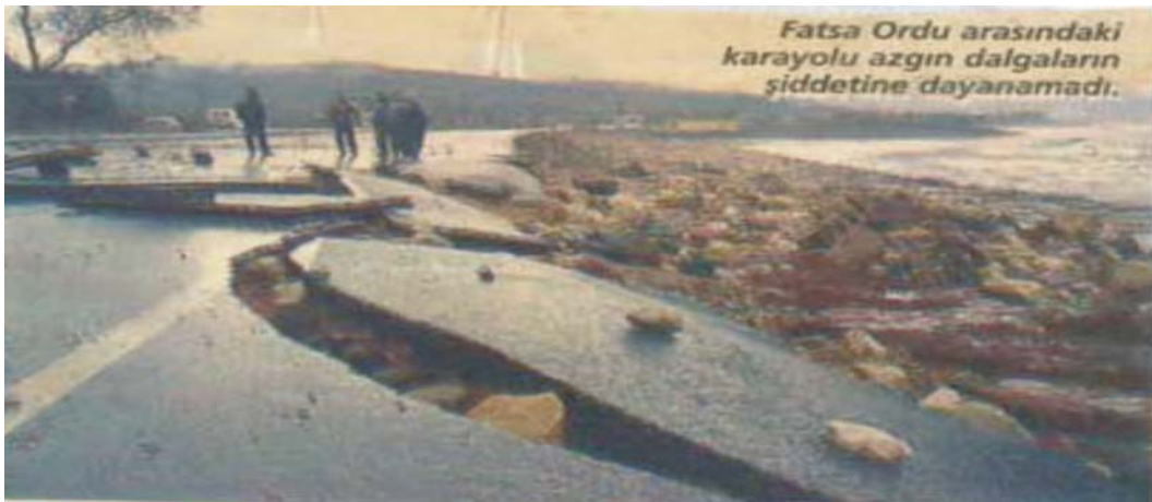
Foto:85 Fatsa Ordu arasında ki sahil yolu meydana gelen fırtınada dalgalara dayanamamış ve bir bölümü zarar görmüştür. (Milliyet Gazetesi 10.12. 2002)
