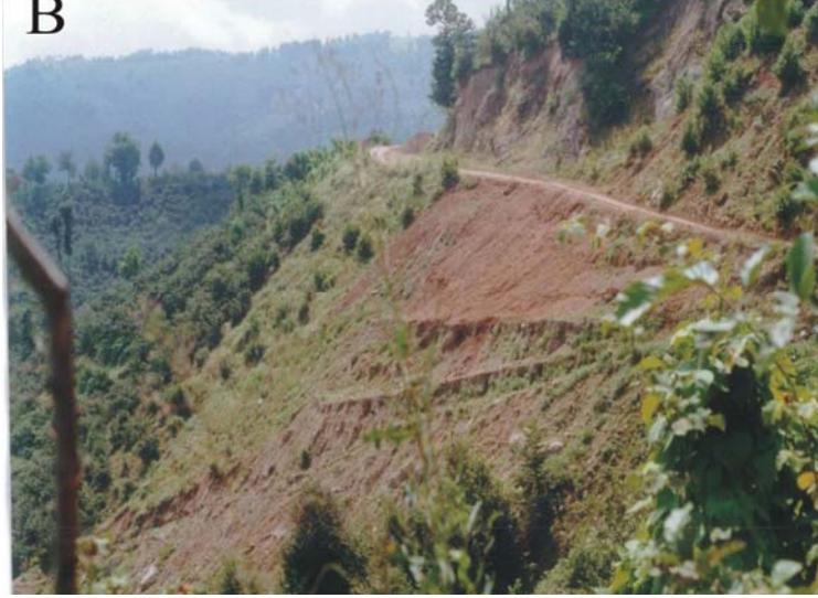
Foto: 65 A, B Çamaş'ın kuzeyinde Çamaş yolunu da etkileyen, yağışlardan sonra meydana gelen heyelan.
