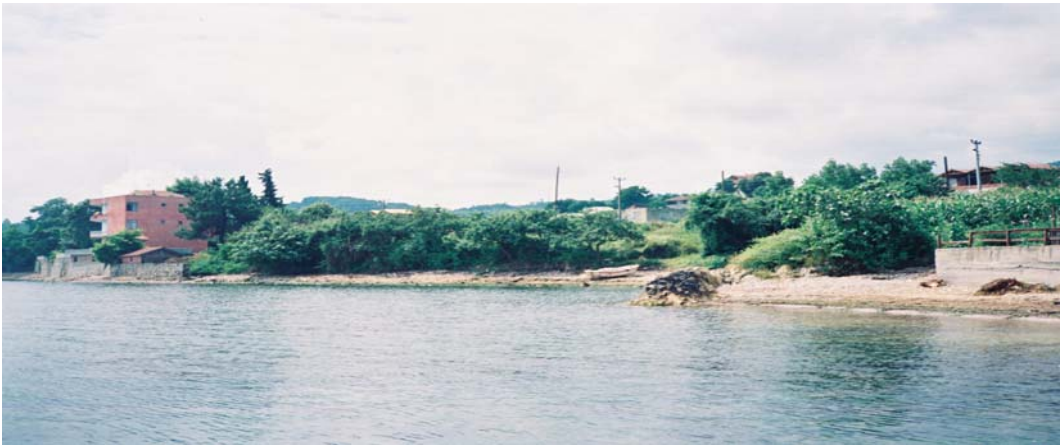
Foto:84 Kıyı çizgisine yakın kıyıda yer alan binalar, istinat duvarlarıyla dalgaların tahribatından korunmaya çalışılmaktadır.
