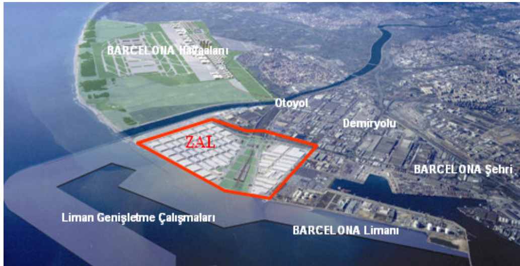
Şekil 2.7: Barselona Lojistik Köyü - ZAL (Zona d’ Activitats Logistiques)
