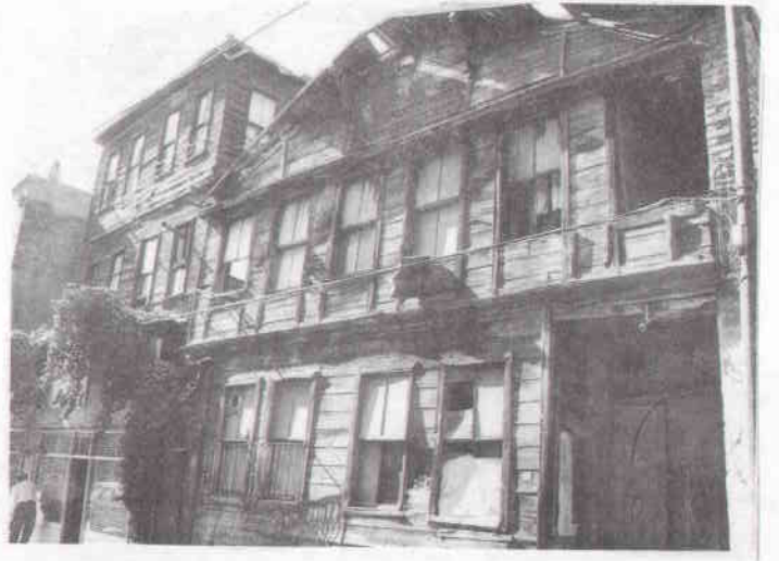
Resim Nu.: 142 Neva Sokađı'ndan görünüm.
