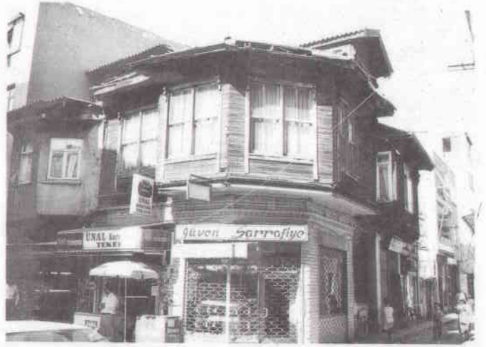
Resim Nu.: 148 Kasımpaşa Fırın Sokağı'ndaki 11 numaralı alt katı tuğla, üst katı ahşap kaplamalı bir mesken.
