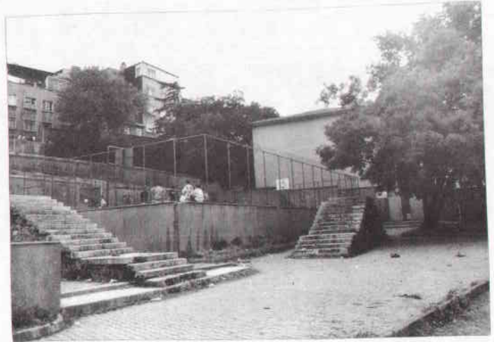
Resim Nu.: 62 Kasım Paşa Mevlevihanesi; Mekan girişinin günümüze ulaşabilen merdivenleri - 1996.
