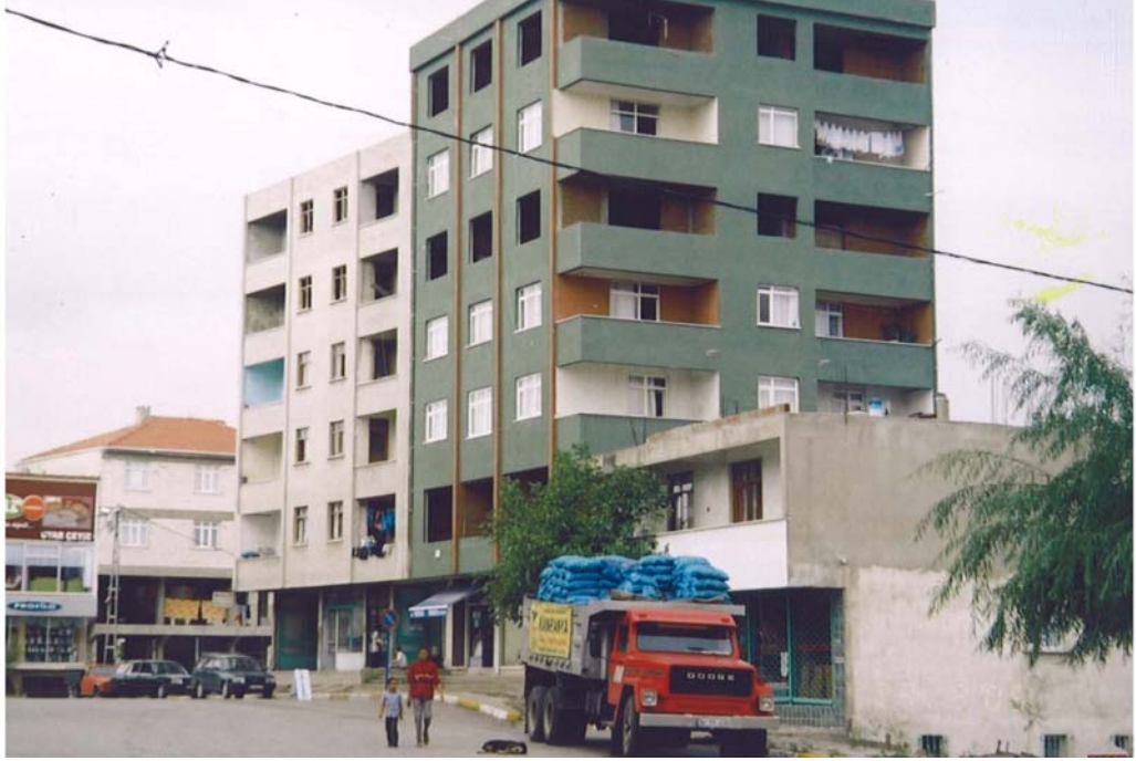
Fotoğraf 19: Şifa Mahallesi'nde Yeni Yapılan Çok Katlı Binalar
