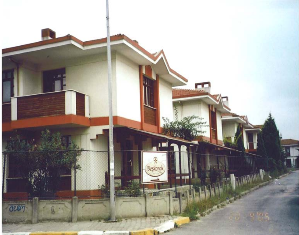
Fotoğraf 10: İstasyon Mahallesi'ndeki Villalardan Oluşan Sitelere Örnek, Beşkonak Villaları
