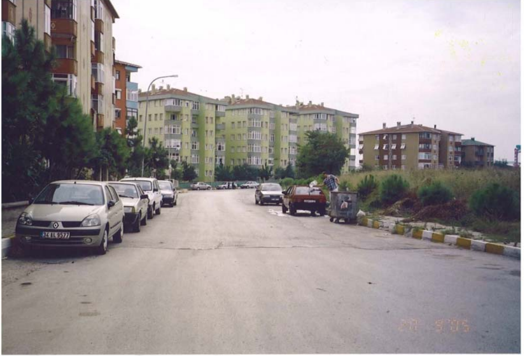
Fotoğraf 23: Hat Boyu Caddesinde Site Şeklindeki Konutlar
