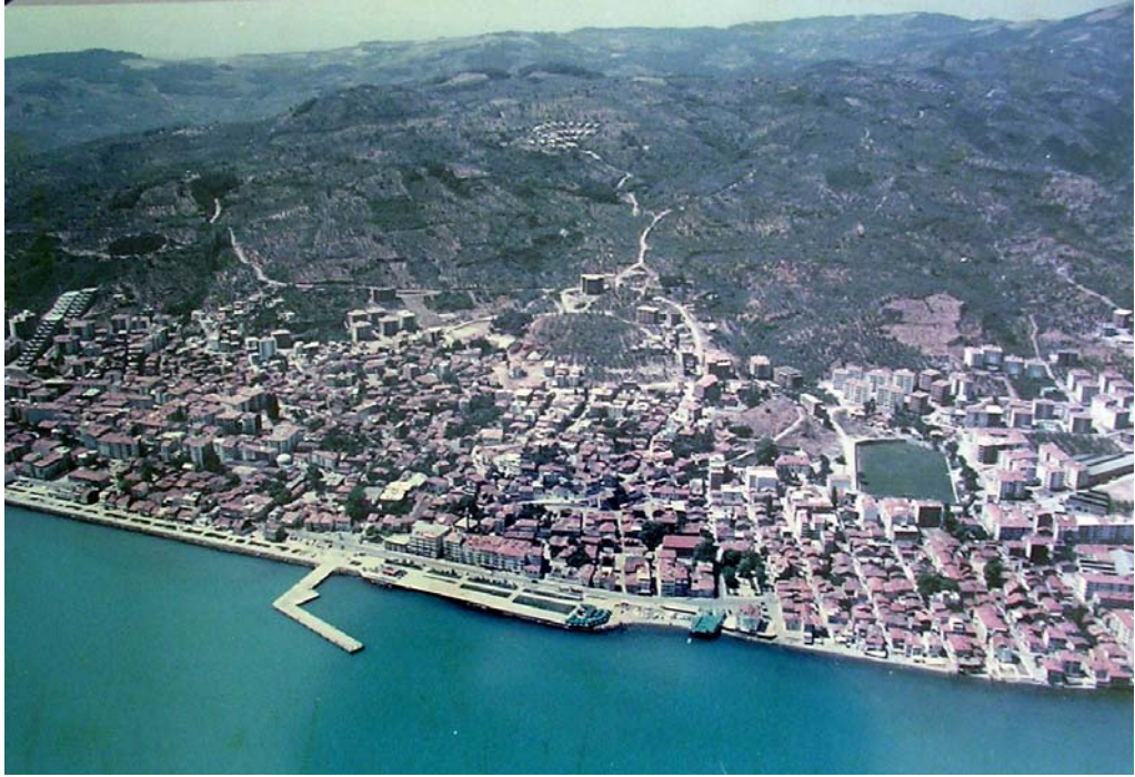
Şekil 4.39 Kentteki yapılaşmadan genel bir görünüm (Mudanya Belediyesi Arşivi)
