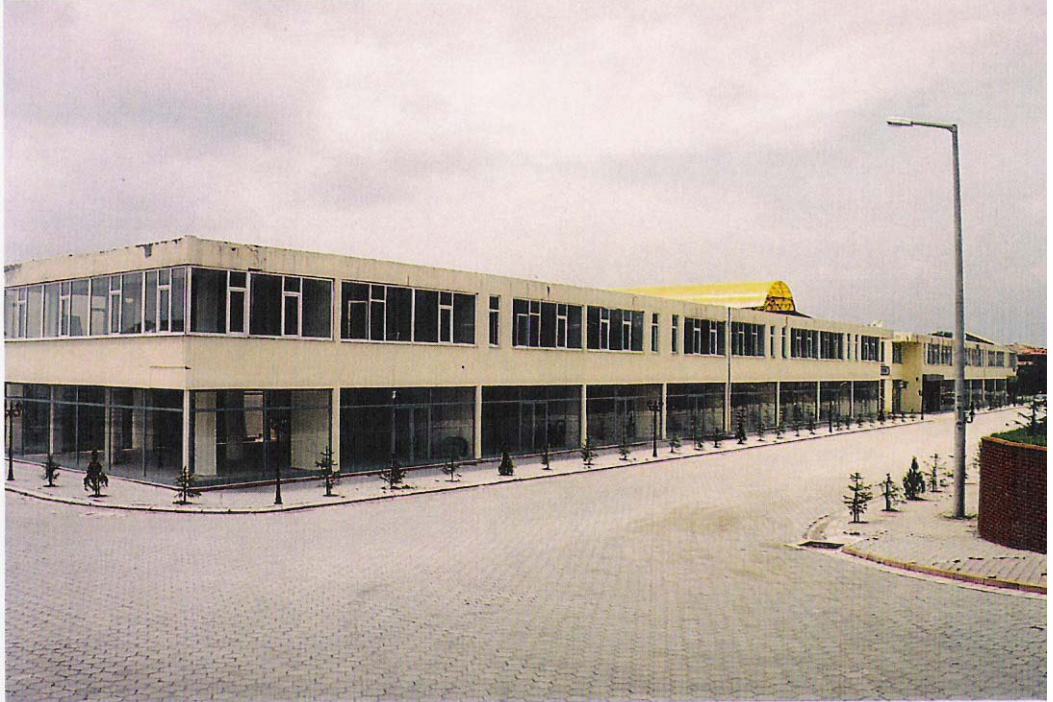
FOTO : 26 Hendek Belediyesi Ticaret Merkezi
