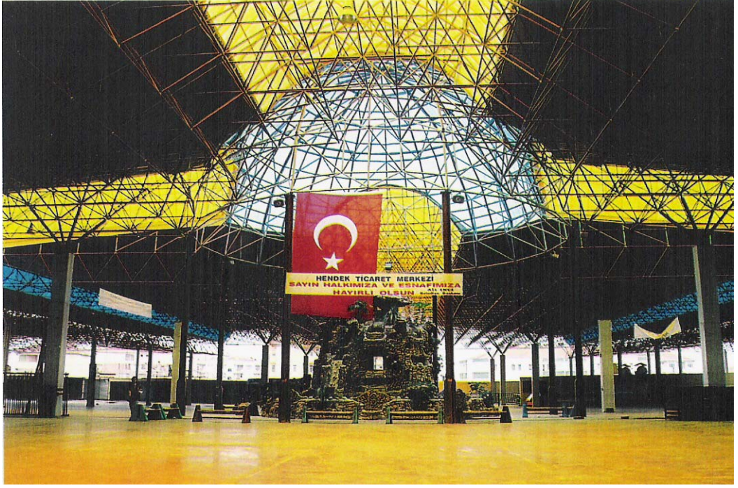
FOTO : 25 Hendek Belediyesi Ticaret Merkezi
