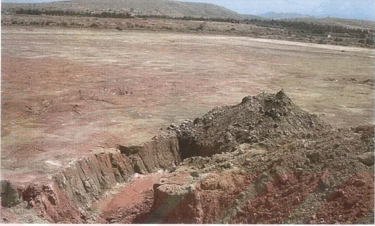
Foto 15: Buharlařma sonucu atık havuzu zemininde oluřan bakır, kükürt ve demir ierikli tabaka
