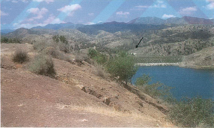
Foto 20: Gölet'in üst kısmındaki bendin gerisinde yer alan eski atık barajı
