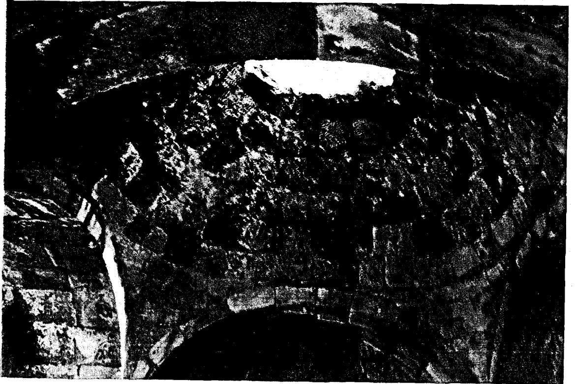
Resim 112 : Güney Martyrion, iç mekan üst örtü sistemi
