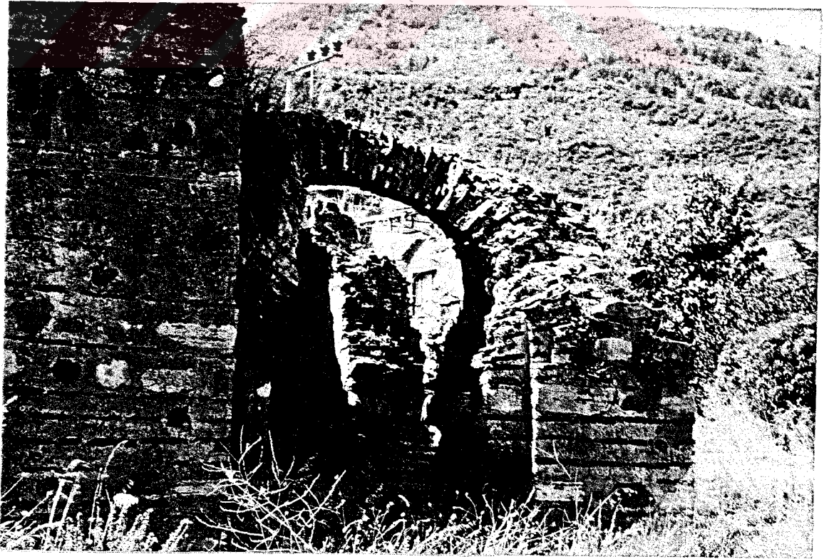
Resim 58 : Kurşunlu Kilisesi, narteksin kuzeybatı cephesi
