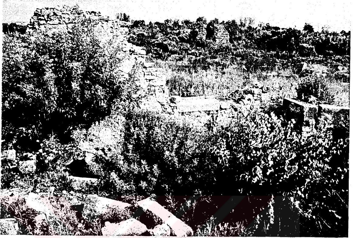
Resim 119 : Çiftte Martyrion, güneydeki yapı, iç mekan köşe duvarları
