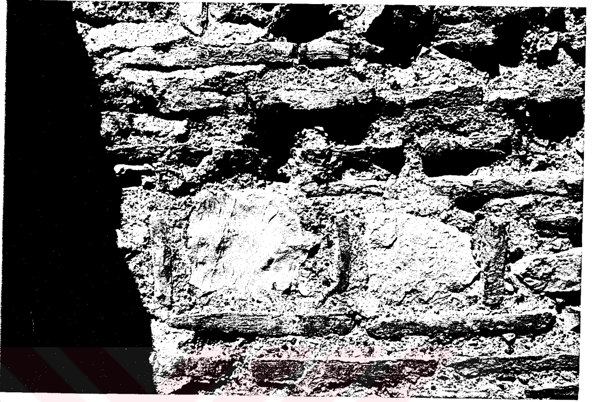
Resim 107 : Yenişehirkapı Kilisesi, duvar dokusu
