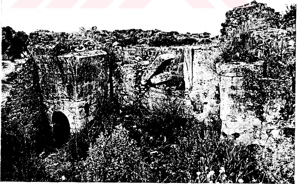
Resim 118 : Çiftte Martyrion, kuzeydeki yapı, iç mekan köşe duvarları
