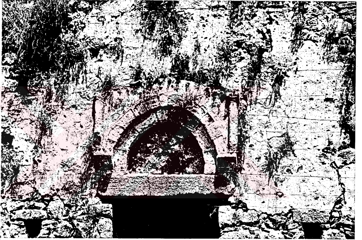
Resim 128 : Arap Evliyası Şapeli, batı giriř cephesi alınlığı
