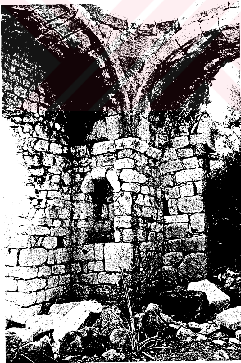
Resim 141 : Boğsak Adası Şapeli, naos iç mekanı güneybatı köşe duvarı
