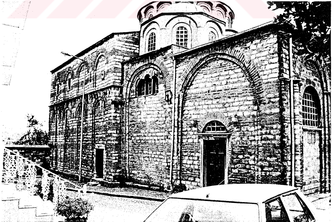
Resim 10 : Khoran Kilisesi, dıştan kuzey cephe
