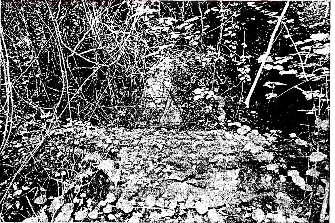
Resim 50 : Hagios Panteleimon Kilisesi, kuzey cephe önündeki duvar kalıntısı
