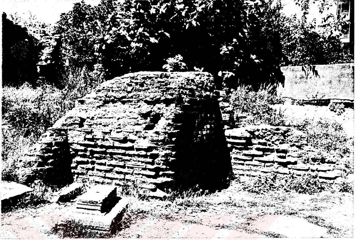
Resim 85 : Koimesis Kilisesi, naos iç mekanı güneybatı köşe duvarı
