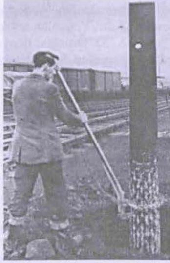
Şekil 15.12: Kobra metodunun dikili direklerde uygulama şekli.
