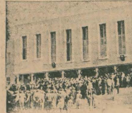
Malatya belediye binası
