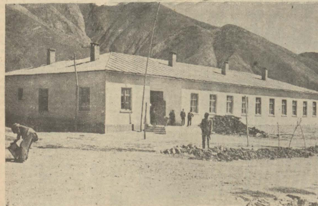
Hakkâri Orta Okulu. Binanın yarısı İlk O Kuludur.
