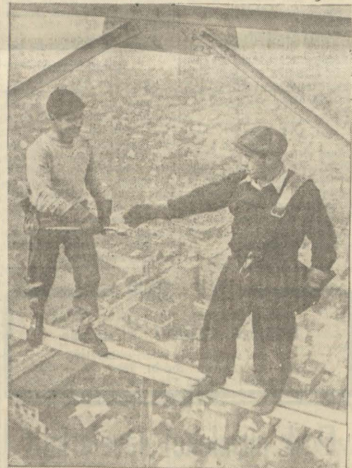
200 metre yükseklikte dar bir iskele üzerinde şakalaşan iki işçi
