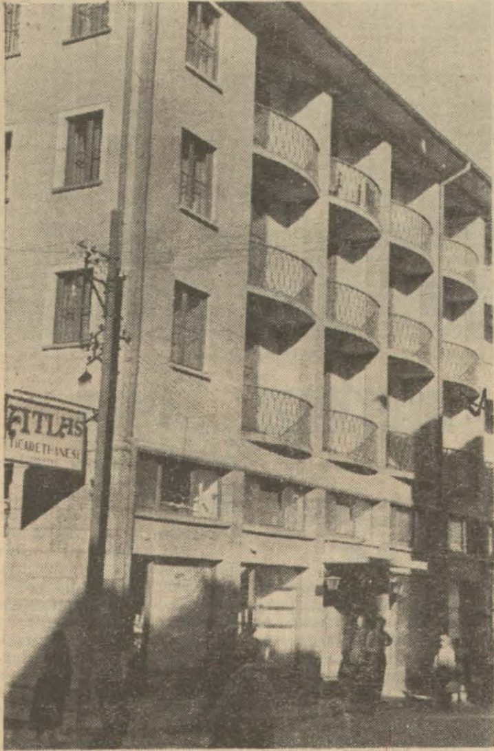
İnkişaf halindeki Sivas'a yakışan modern bir tesis: Belediye Otel ve Lokantası.
