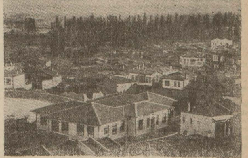
Korkunç bir heyelâna uğrayan Gördesten bir görünüş
