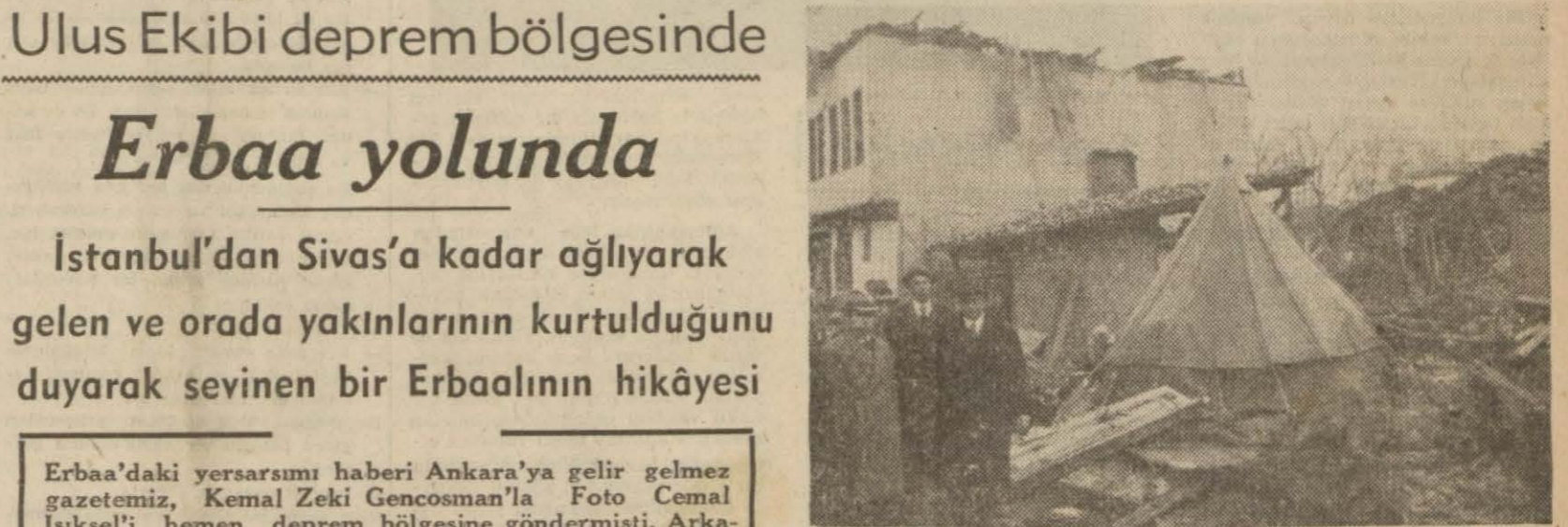
Yukarıda: Erbaa'da Kızılay çadırlarına yerleştirilen felâketzedeler. Ortada: Sıhhat Vekilimiz Erbaa yıkıntılarını tetkik ediyor. Aşağıda: depremden sonra yıkılan Talazan köprüsünün kalıntıları
