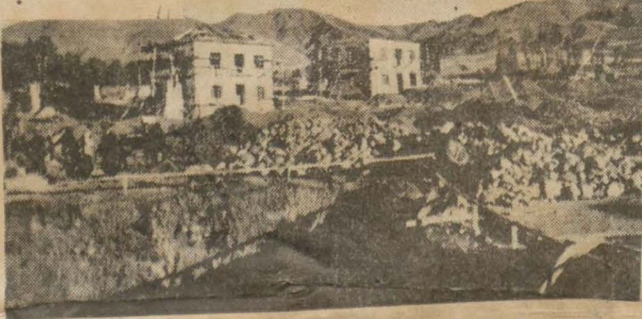
Erzurum, Trabzon yolundan bir görünüş ve Erzurum'da yapılan modern mahallenin evleri inşa halinde
