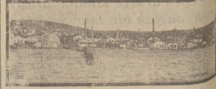
Güzel Ayvalık zeytinyağı fabrikaları
