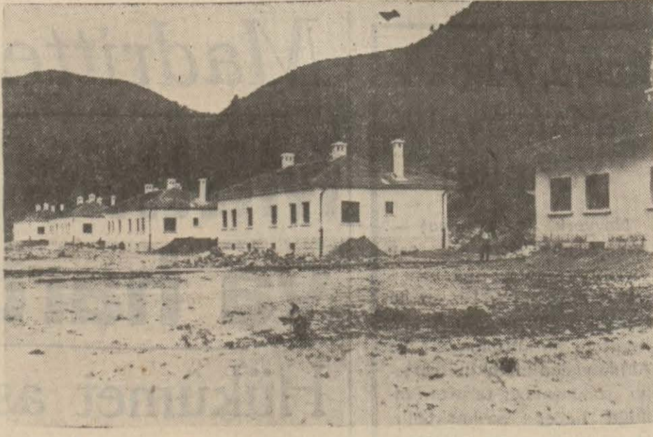
Çatalağzı İstasyonunda inşaat faaliyeti
