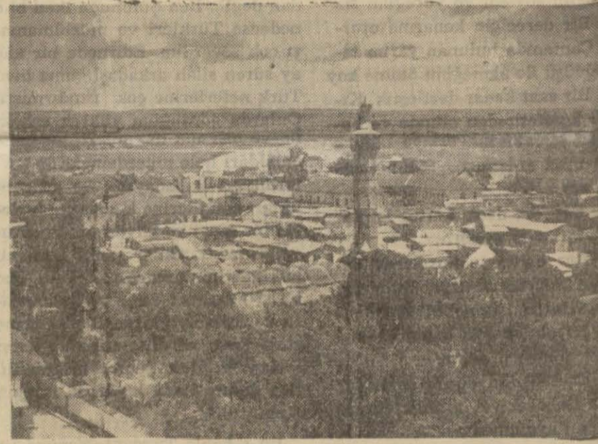
Adananın umumî görünüşü
