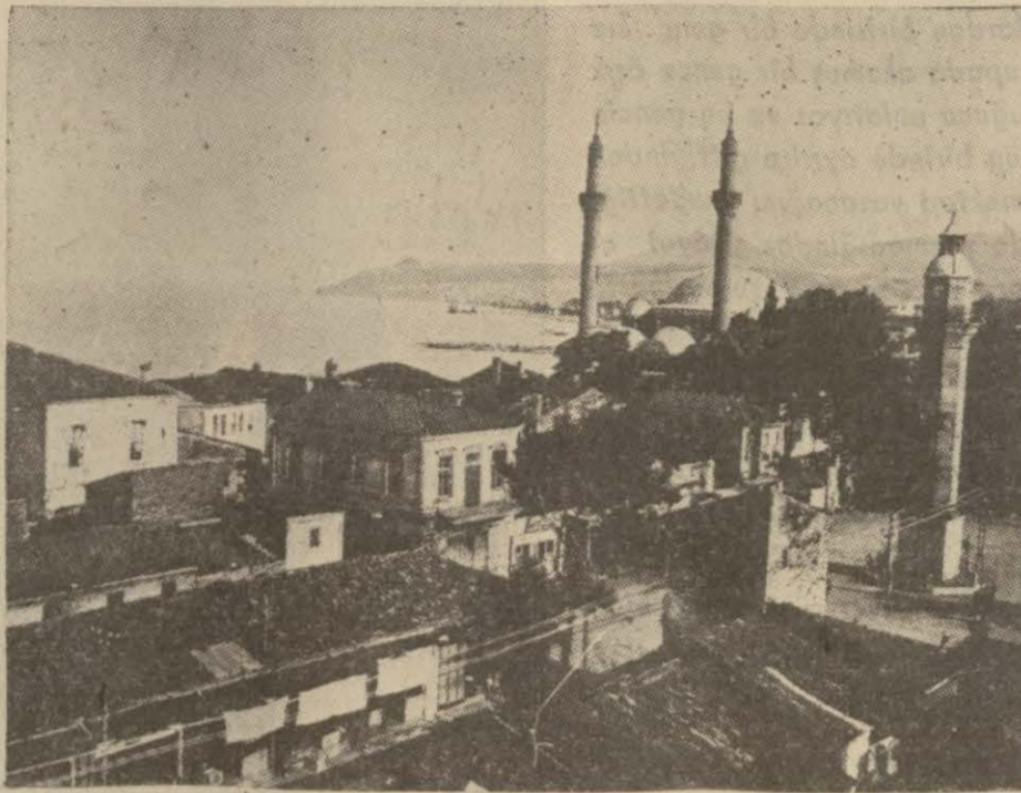
Elektrik tesisatı son günlerde bazı arızalar geçiren Samsunun güzel bir manzarası
