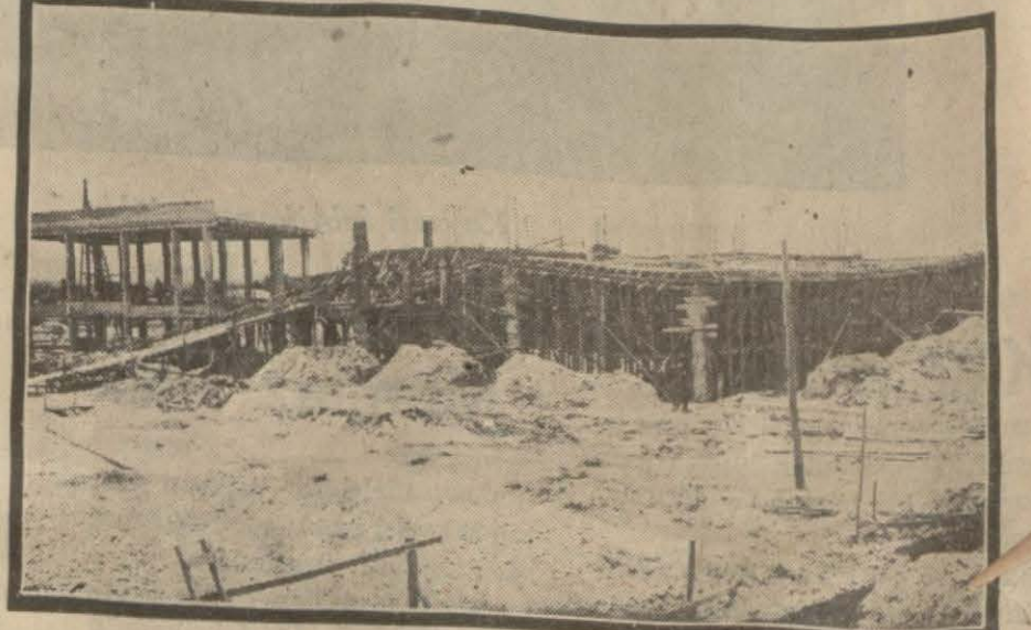
Fabrikada itfaiye garajı inşaatı
