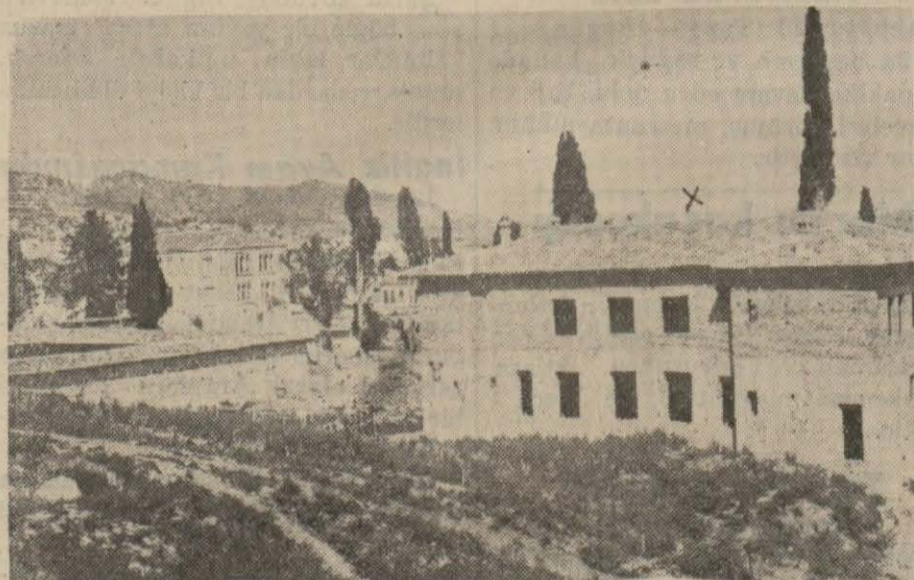
Yapısı yarıda kalan ilim evi binası
