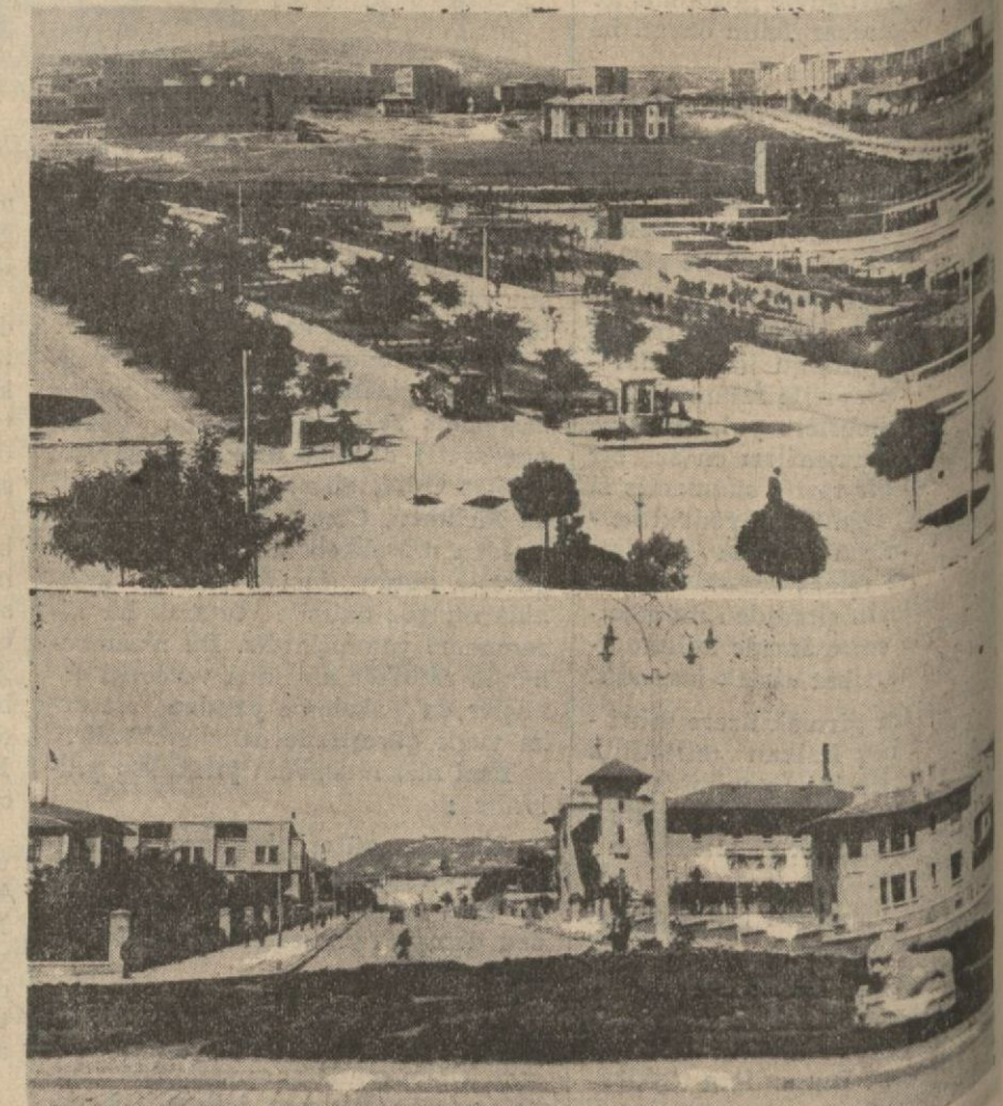
Emniyet meydanından Devlet mahallesine bir bakış — İstasyon caddesi asfalt döşeniyor.
