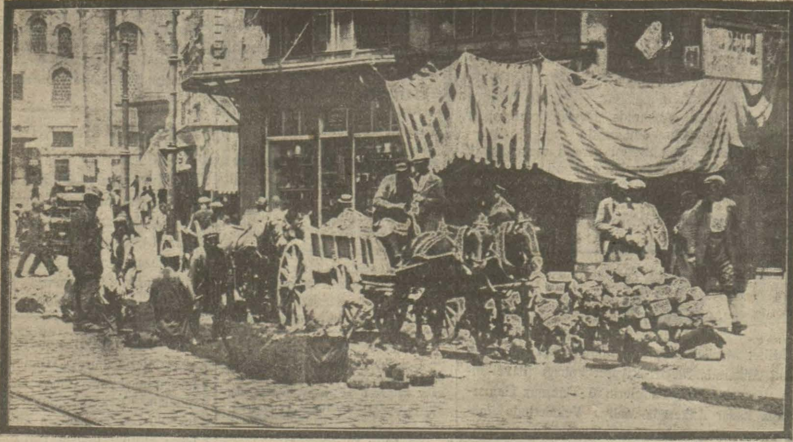
Istanbul cihetinde devam eden kanalizasyon ameliyatından Sultan hamamındaki kısmın gösterdiği manzara
