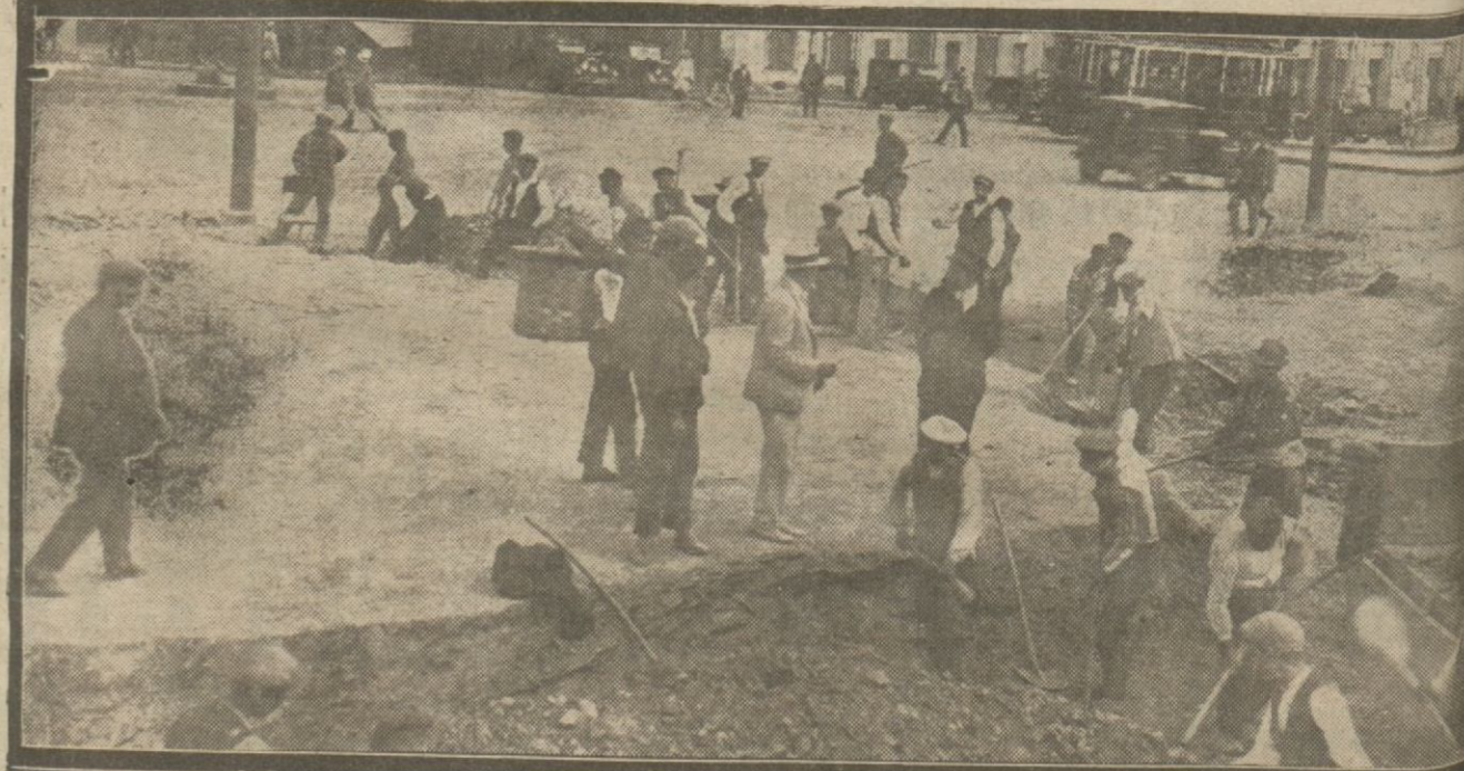
Taksim meydanının güzelleştirilmesi için ameliyata başlanmıştır. Tesviye çalışmaları yapılmaktadır.
