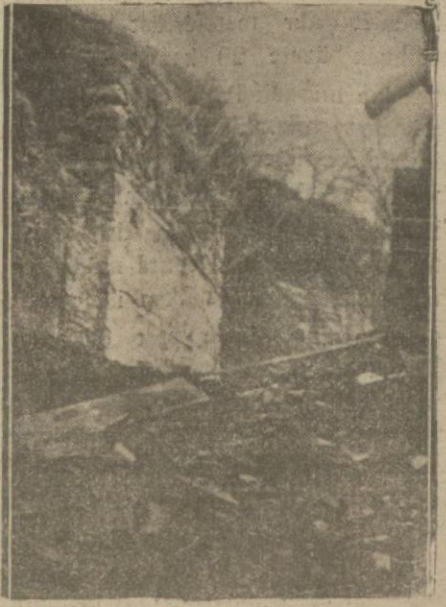
Evelki geceki fırtına bazı mahallelerde hasarati mucih olmuştur. Bu resim fırtınada yıkılan bir evi gösteriyor.
