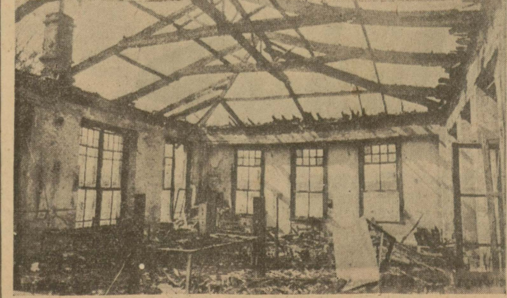
Fabrika itihaz edilen binanın infilaktan sonraki hali
