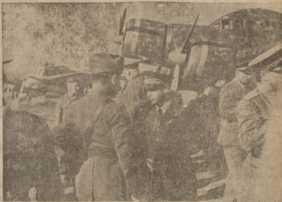
Le sous-secrétaire d'Etat à l'aéronautique, S. E. Fougier, inspecte des détachements de l'aéronautique italienne en Libye.
