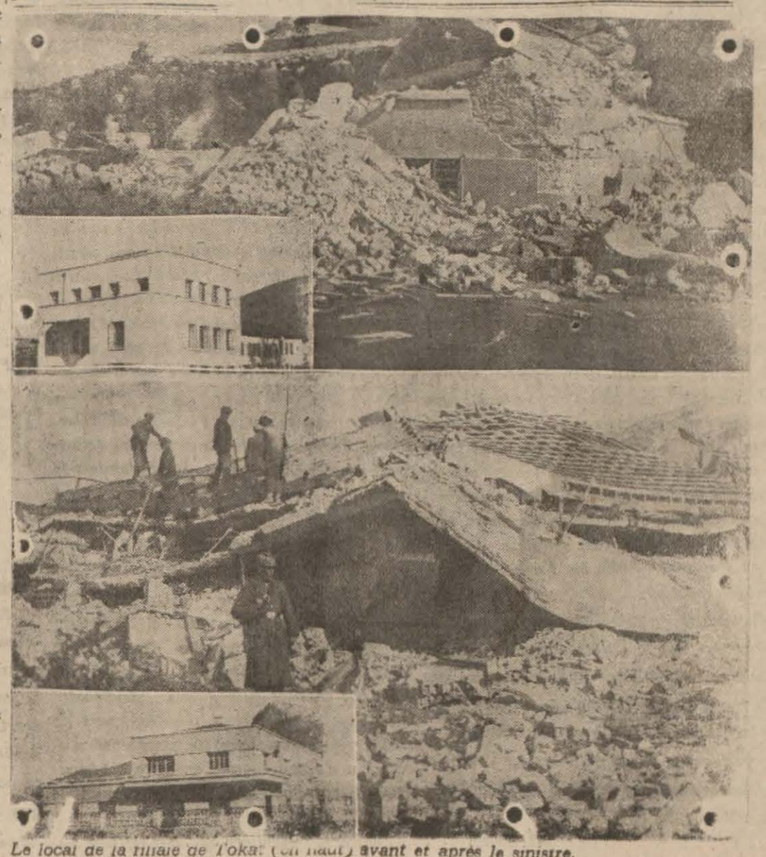
Le local de la maison de Tokat (en haut) avant et après le sinistre.
