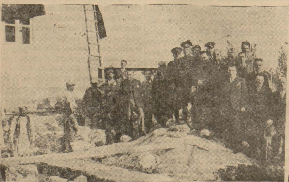
La pose de la première pierre du nouveau Halkevi de Gelibolu
