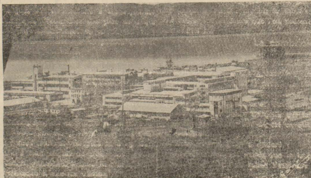
Une vue générale de la papeterie d'Izmit.
