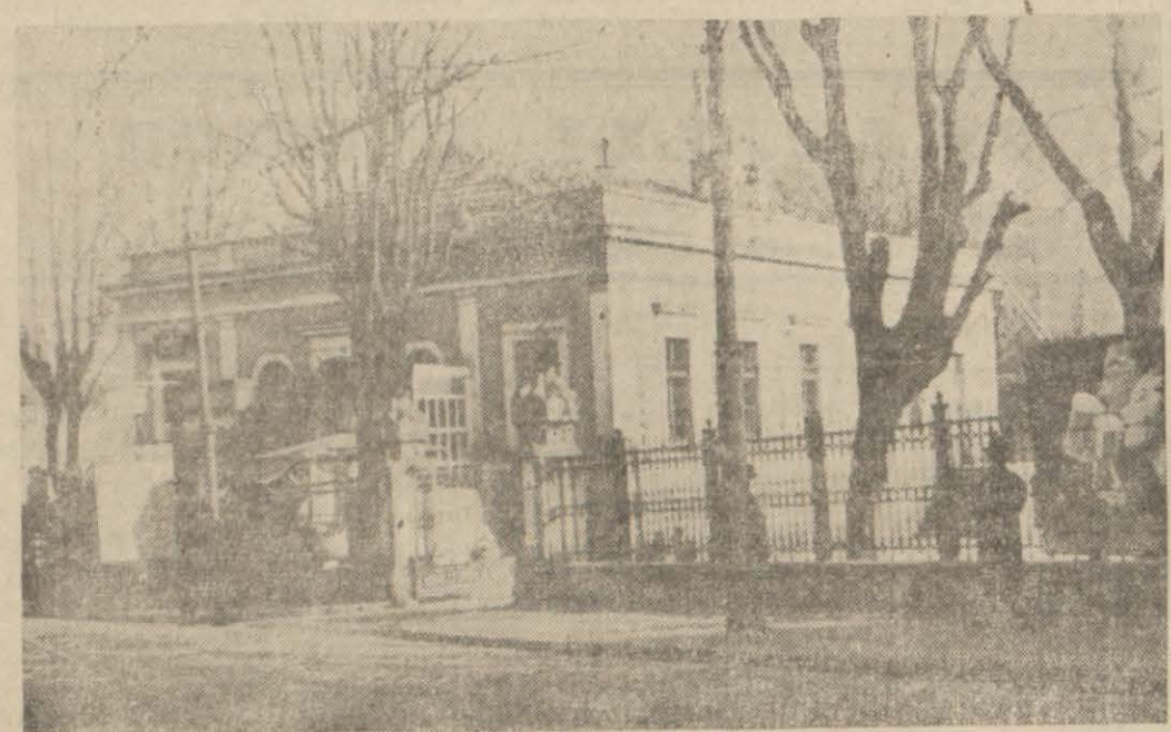
Le casino de la station à Sirkeci dont la démolition a été décidée
