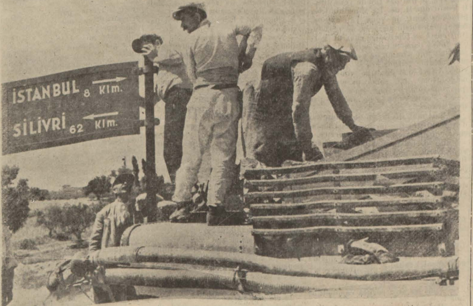
On a commencé à poser sur la route nationale Istanbul-Silivri tous les signaux du code international de la route. Ce travail sera continué jusqu'à Edirne. Notre cliché montre la pose d'un signal à 8 kilomètres d'Istanbul et de 62 de Silivri.
