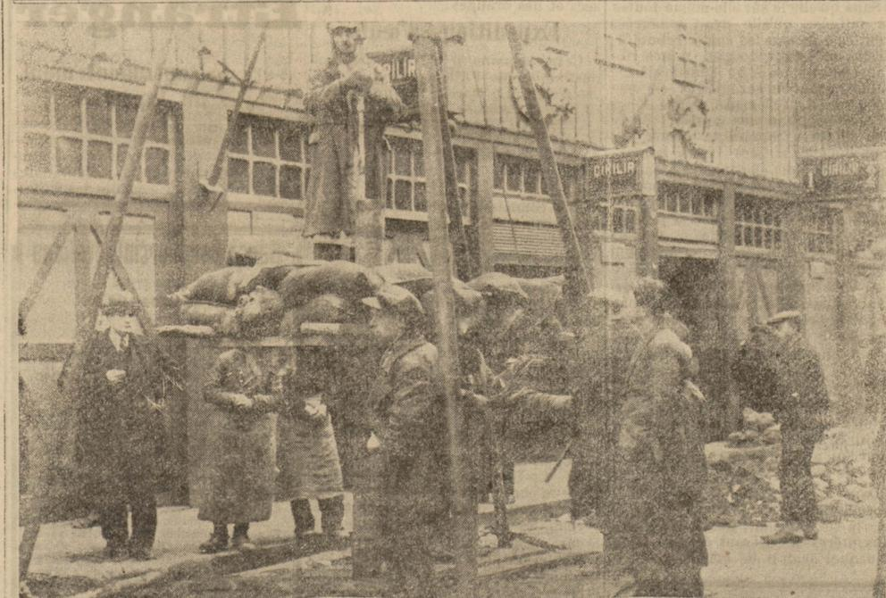
On sait que l'on projette la construction d'un grand immeuble, du côté de la sortie du tunnel à Galata. On a entamé les travaux de sondage pour pouvoir établir l'endroit où seront posés les fondements. On a trouvé de l'eau de mer à 5 mètres du sol et à 10 mètres on a rencontré une couche de boue. On sera donc obligé de creuser plus profondément. Notre cliché montre les opérations de sondage en cours.
