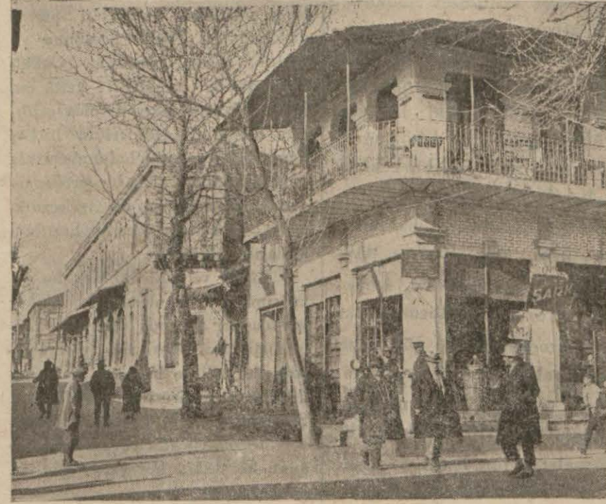
Uşak'ta asfalt yolun görünüşü.
