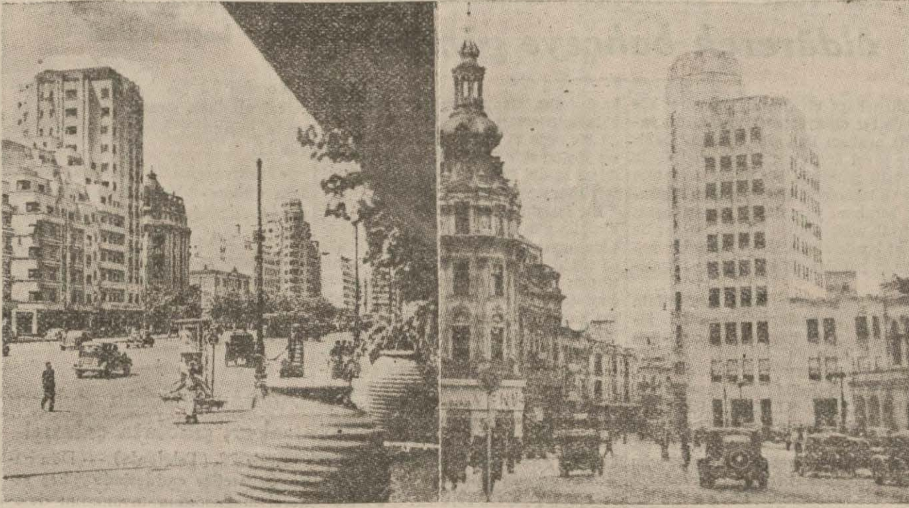
Şiddetli bir zelzele neticesinde hasara uğrayan Bükreş şehrinde bir cadde ve telefon santrali
