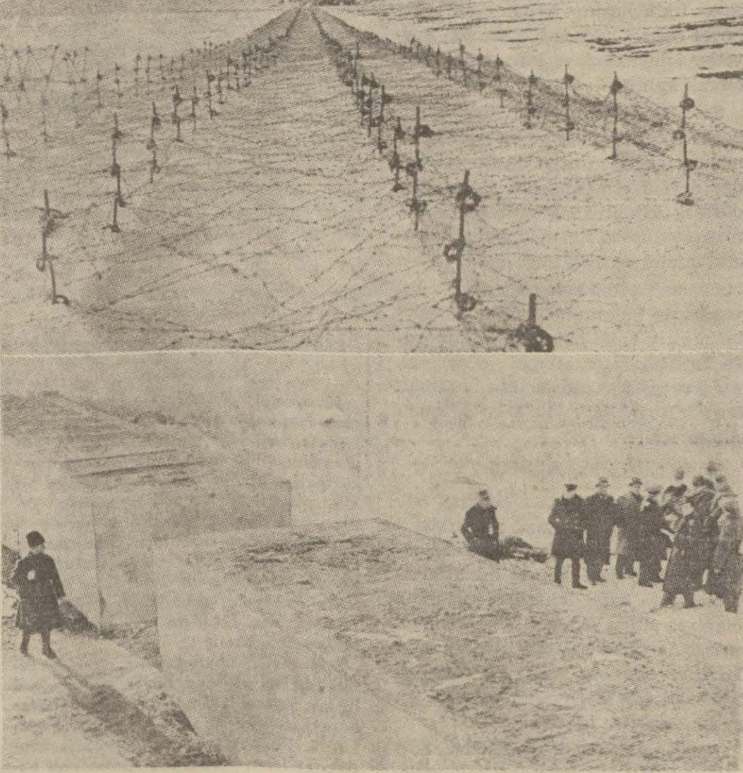
Karol hattının önündeki dikenli tel mâniâları ve 3 metre genişliğindeki beton mâniâ
