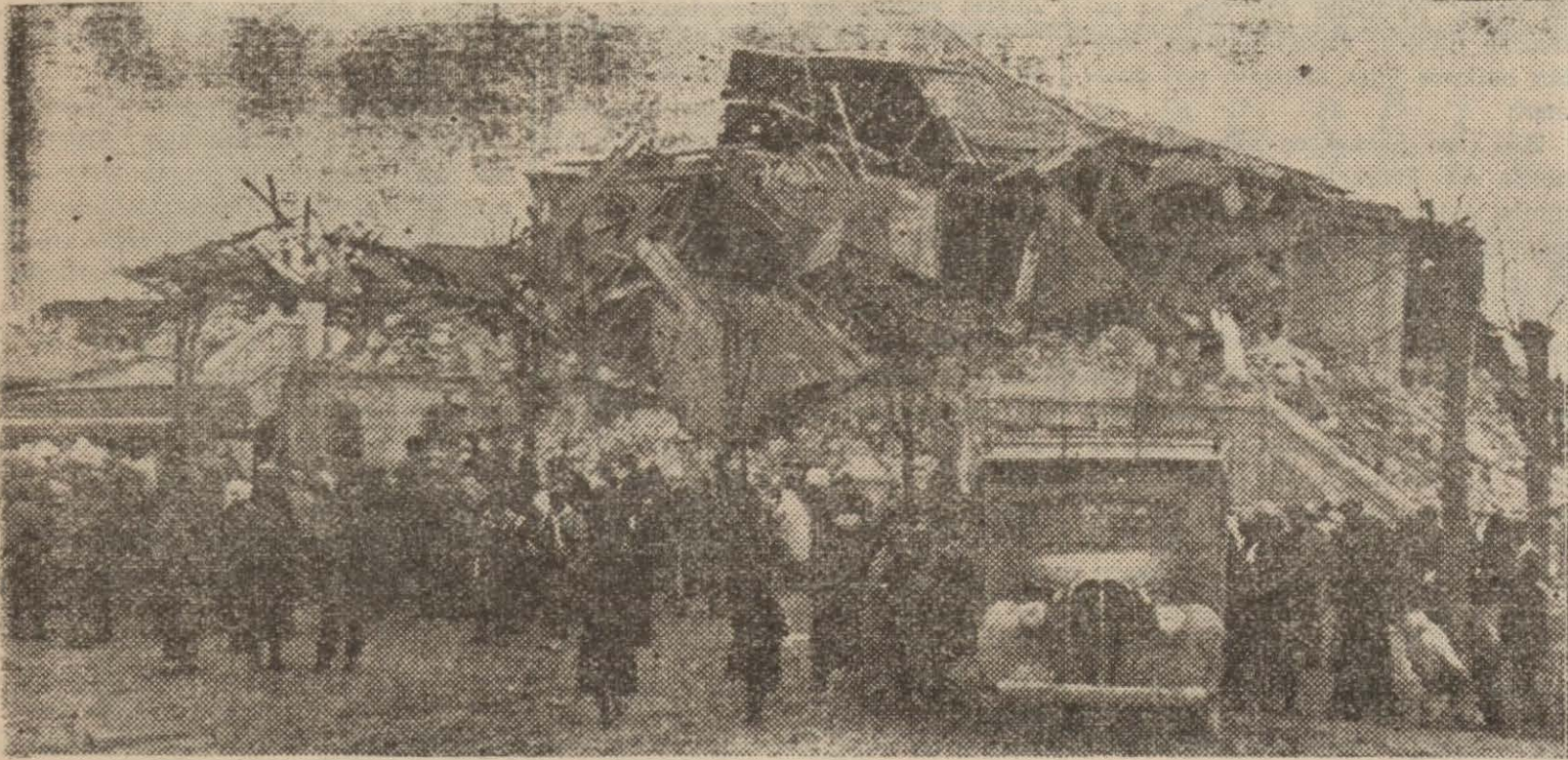
Erzincanda yıkılan binalar ve enkazın kaldırılması işi
