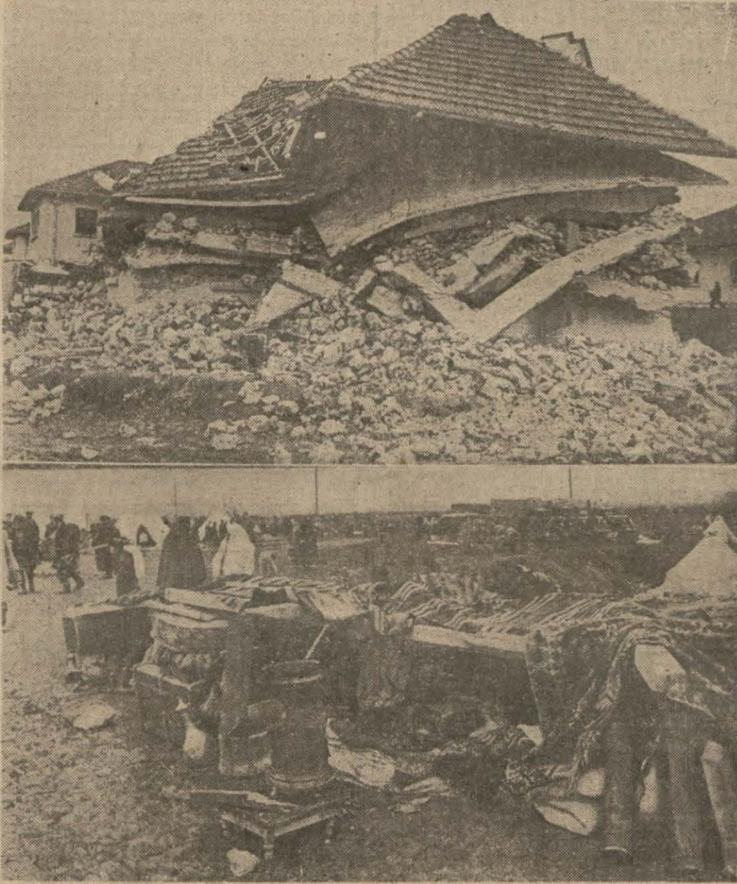
Erzincanda yıkılan bir bina ve enkaz altından çıkarılan eşyalar
