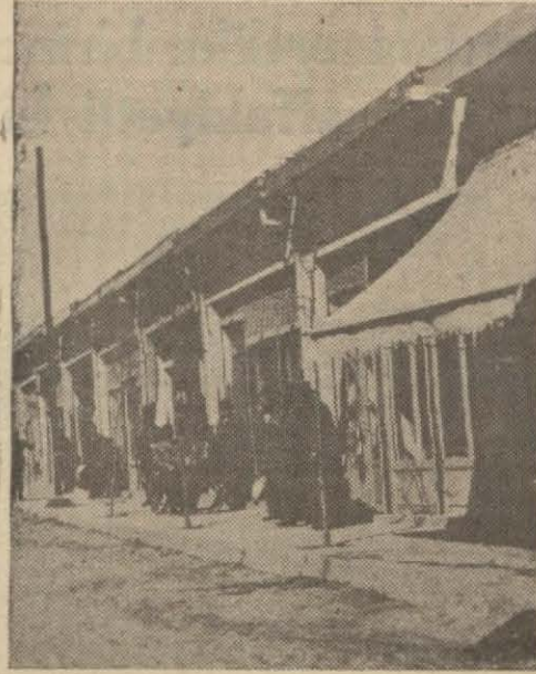
Kırşehirde yeni yapılan dükkânlardan bir görünüş
