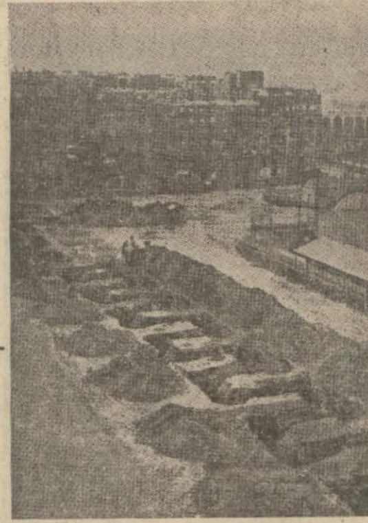
Paris etrafında kazılmakta olan siperlerin görünüşü
