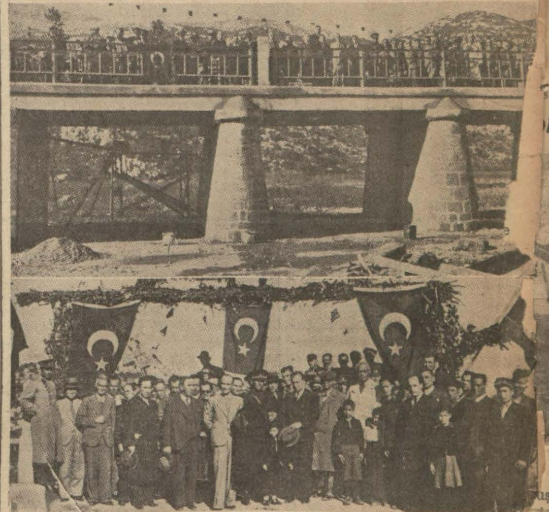
Yukarıda yeni açılan köprü, aşağıda açılış töreninde bulunanlar
